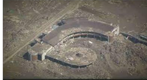
図2 被災後の大川小学校
