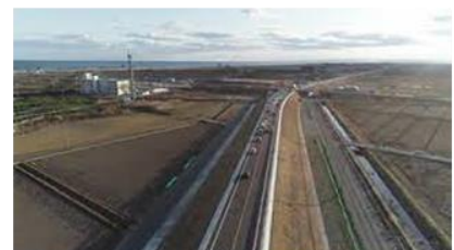
図3 かさ上げ道路
