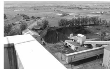
環境に有害な物質を排出していないか、常に監視しています。この発電所では全道のほぼ4%を供給しています。発電所が川や海に隣接するのはタービンを回転させた高温の蒸気を冷却するため大量の水が必要となるのです。向こうに見えるのが、石狩川と奈井江の発電所です。
