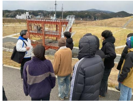
図8 南三陸町視察 防災対策庁舎
